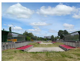
Budowa trasy tramwajowej na ulicy POWSTAŃCÓW ŚLĄSKICH (odcinek Radiowa - Górczewska)
