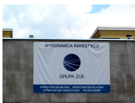
Budowa trasy tramwajowej na TARCHOMIN
