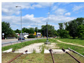
Budowa trasy tramwajowej na WINNICE
