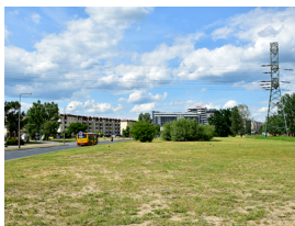
Budowa trasy tramwajowej na NOWODWORY
