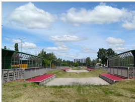
Budowa trasy tramwajowej na ulicy POWSTAŃCÓW ŚLĄSKICH (odcinek Radiowa - Górczewska)
