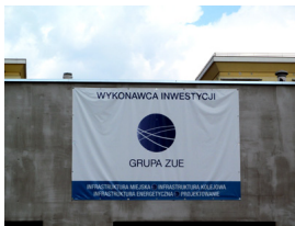
Budowa trasy tramwajowej na TARCHOMIN
