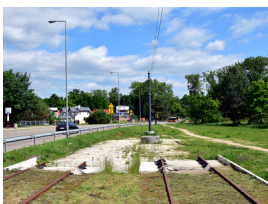
Budowa trasy tramwajowej na WINNICE
